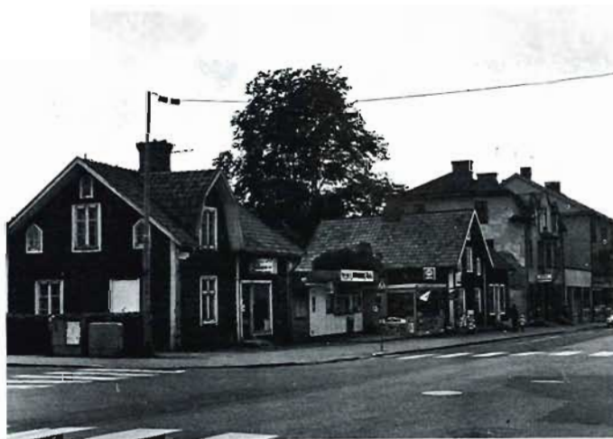
Det lilla timmerhuset i hörnet av Hagendalsvägen och Götgatan har försvunnit. Det var ett av Kumlas äldsta hus, och det bevarade något litet av den karaktär Hagendalsvägen hade då samhället växte upp. Här bodde tidigare en skraddare vid namn Karlsson och senast innehades butiken av Engvalls garnaffär.
