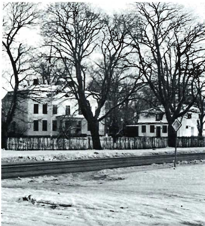
Kumla prästgård i våra dagar. Den äldre byggnaden från 1909 står på den östra sätesbyggnadens plats, den nyaste från 1971 står på samma plats där den södra huslängan stått. Foto förf Kumla kyrkoarkiv.
