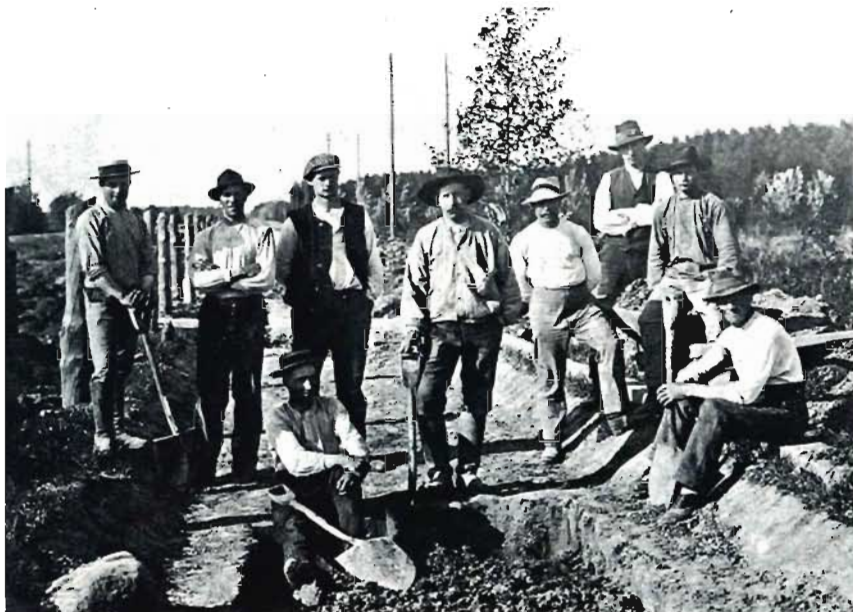
Ett arbetslag med rallare i Viaskogen som byggde dubbelspåret mellan Örebro och Hallsberg år 1917.
