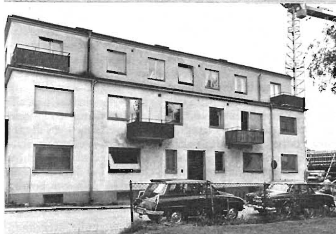
Översta bilden: Odengatan 5, 7 och 9. Mellersta bilden: Sveavägen 1. Undre bilden: Sveavägen 3. Odengatan 5 användes först till kafé senare till livsmedelsbutik. I nr 7 hade bl a E Hallmén specerieraffär, på senare år har där varit herrfrisering. I nr 9 har det bl a varit begravningsbyrå, elaffär, charkuteributik och bar. Sveavägen 1 är gårdshus och nr 3 innehöll bostäder
