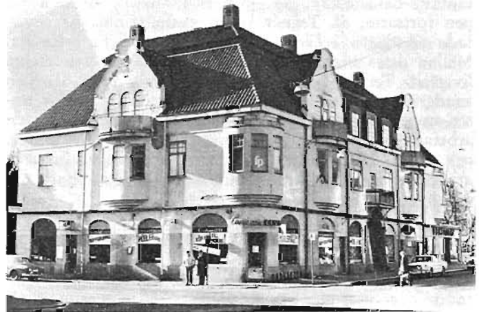
Kumlas under flera årtionden största affärs- och bostadshus i hörnan av Hagendalsvägen—Köpmangatan, uppfört 1914, rivet 1973.
