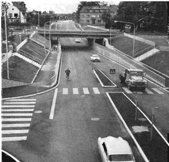
Den nya järnvägsviadukten
