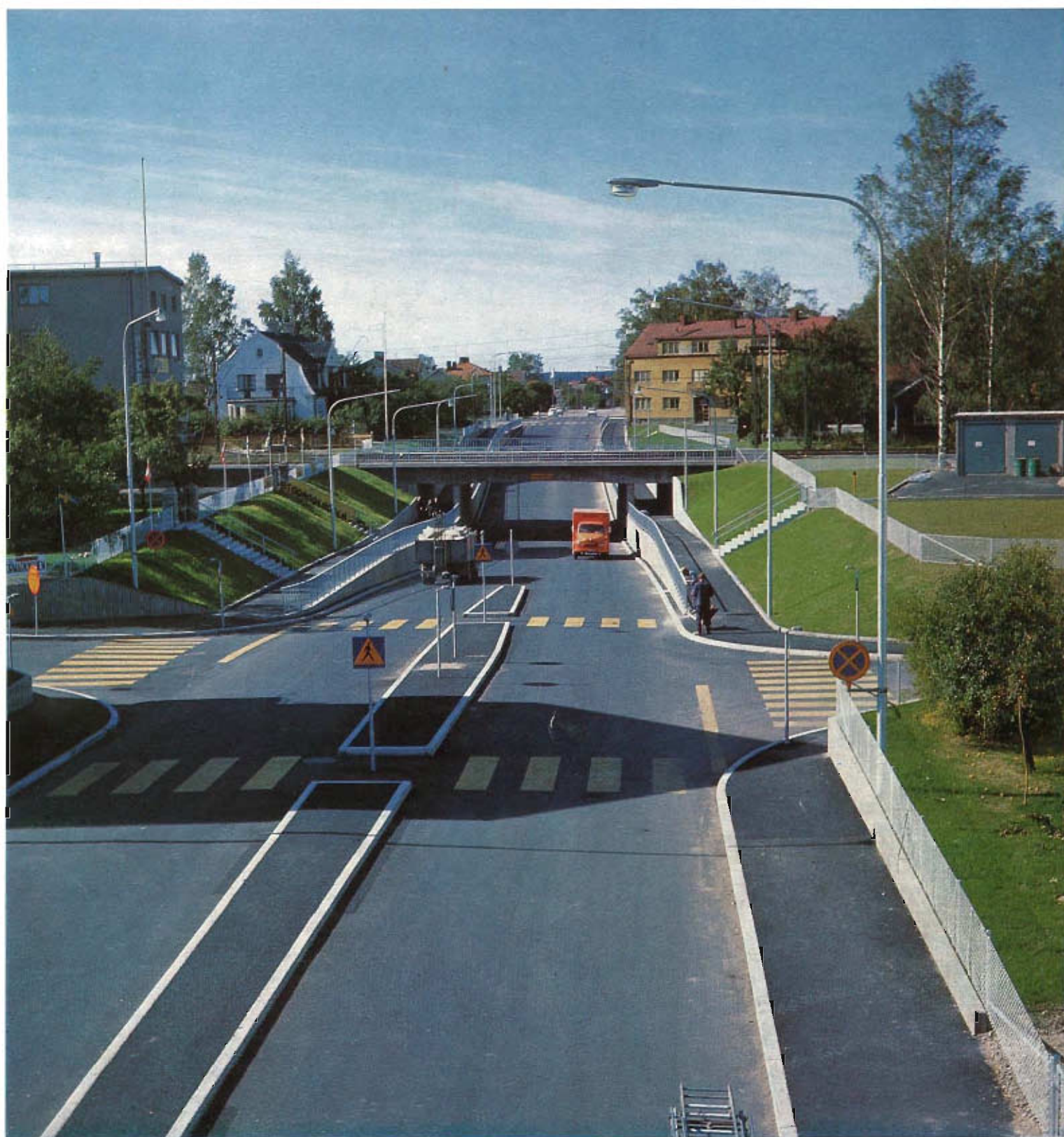
DEN NYA JÄRNVÄGSVIADUKTEN I KUMLA (se art. sid. 15)
