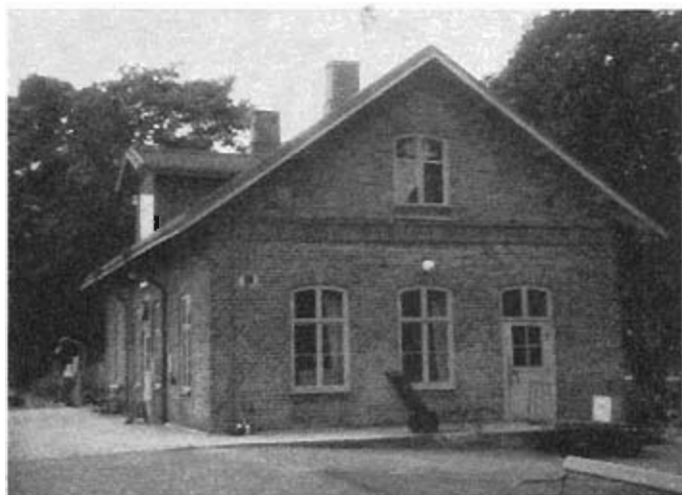
Järnvägsstationen i Åsbro
