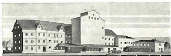
Kontors- och magasinsbyggnaderna.
