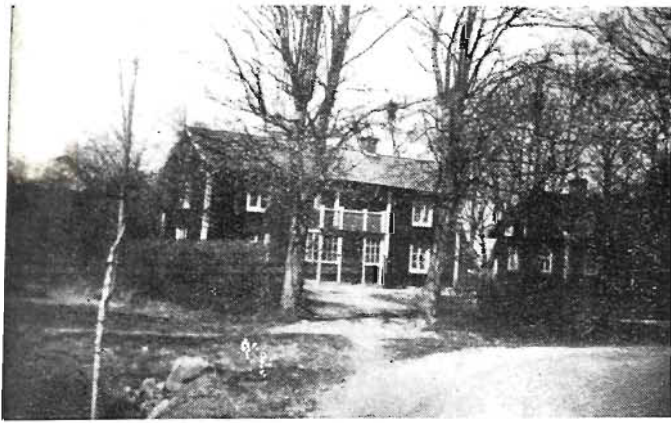
Haget i Södra Mos, där Erik Jonsson föddes
