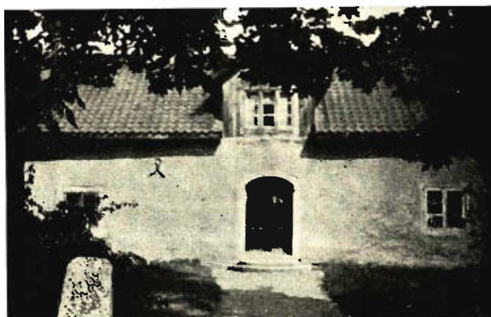
Den 200-åriga byggnaden i Hällabrottet
