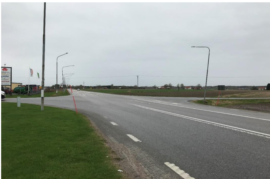
Figur 15 Korsningen väg 529 (gamla E3) och väg 542 behöver ses över. Fotot: Sweco
