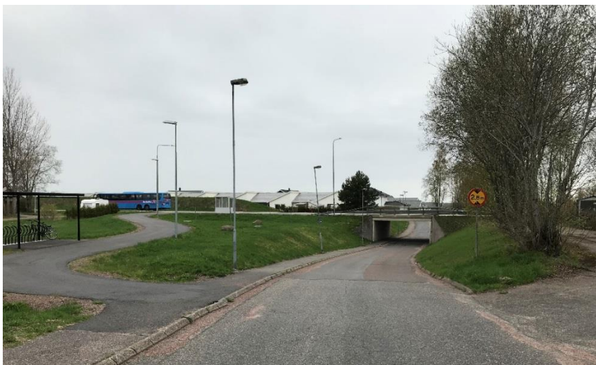
Figur 13. Passagen under väg 529 saknas cykelbana och behöver få en högre standard för cyklister. Foto: Sweco
