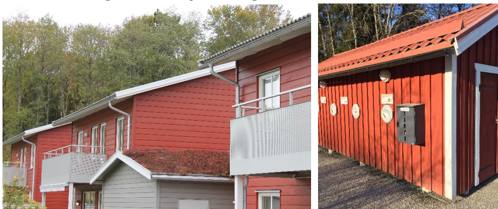
Exempel på grönt tak på komplementbyggnad samt miljöbod.
