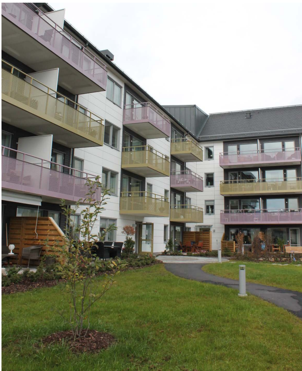
Exempel på flerbostadshus i fyra våningar med grön gårdsmiljö, Kolla Parkstad, Kungsbacka.
