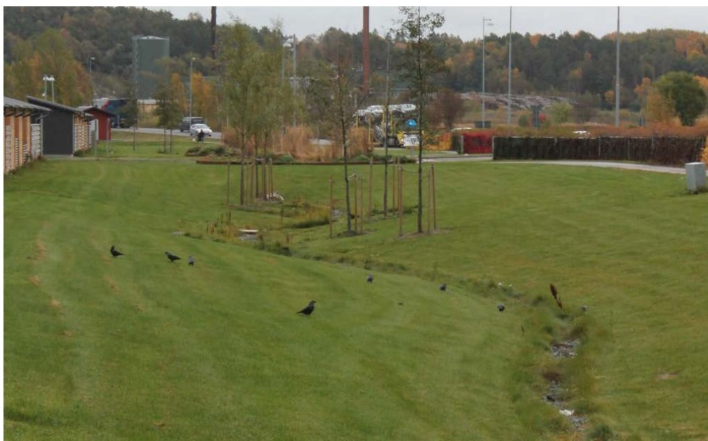
Exempel på grönstråk som även har en funktion för dagvattenhantering, Kolla Parkstad, Kungsbacka.
