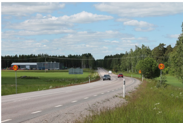
Länsväg 641, åt nordväst
