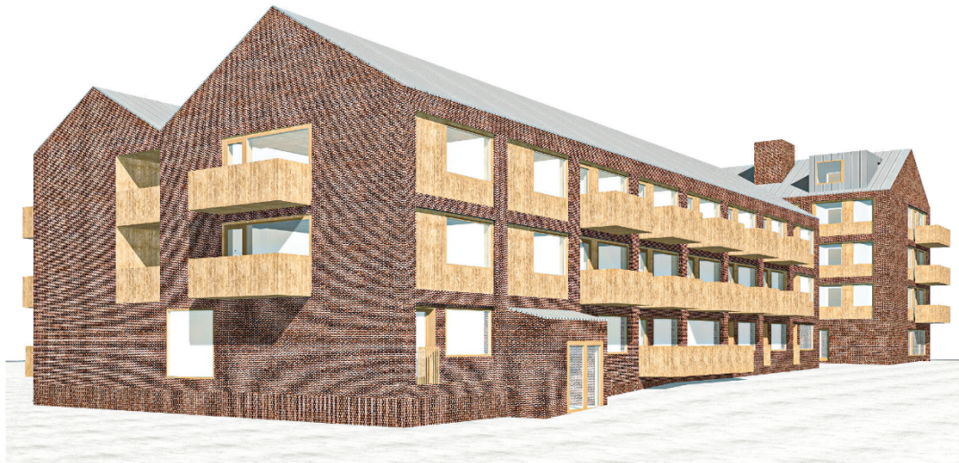
Visandes utstickande entré mot Skolvägen. Tydligt gavelmotiv som visar loftgångarnas funktion i byggnaden.
