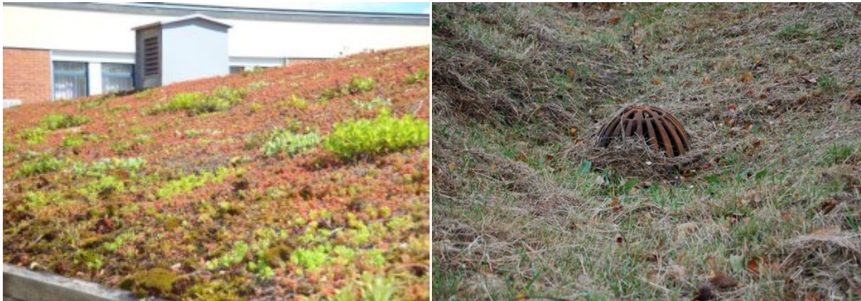
T.v. Gröna tak kan fördröja och reducera det avrunna dagvattnet med mer än 50 %. T.h. Dagvattenbrunn som samlar upp och leder bort dagvattnet.
